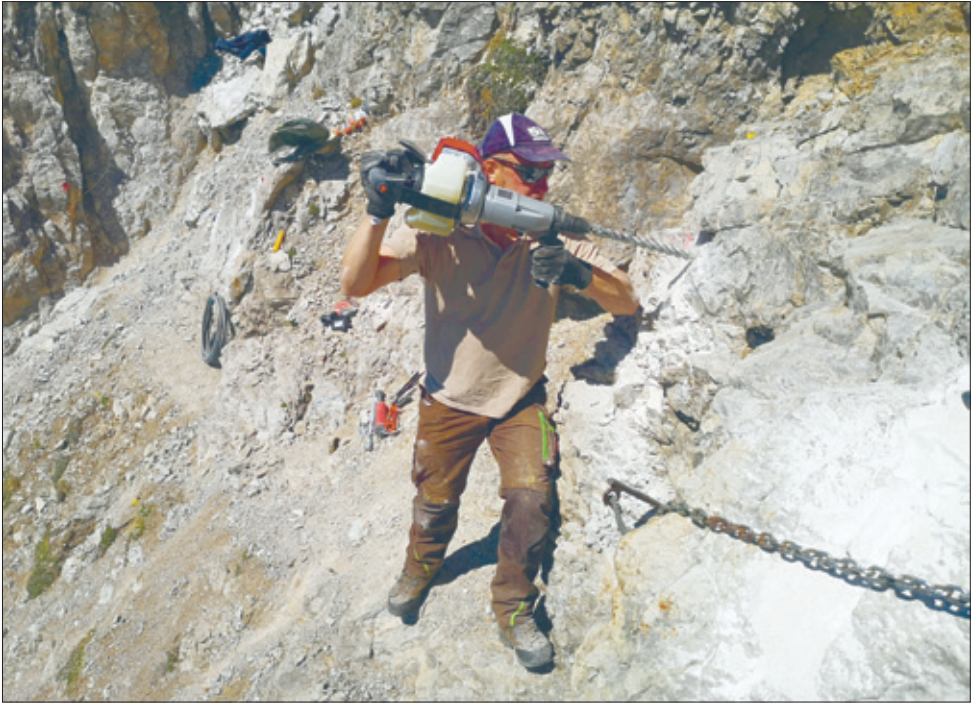
Xaver beim Bohren der neuen Halterungen (Foto G. Baumann)
