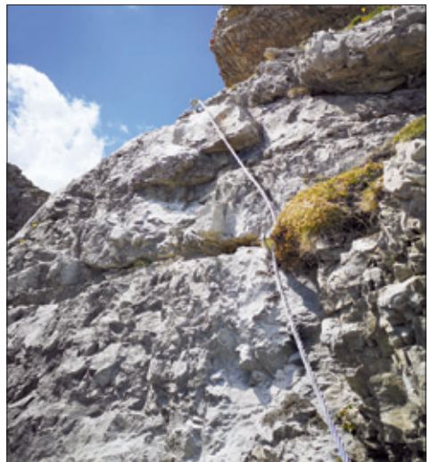
Neue Stahlseile am Litnis (Foto G. Baumann)
