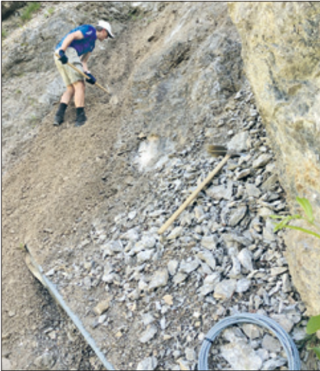
Freilegen des Wanderweges im Krottental (Foto G. Baumann)
